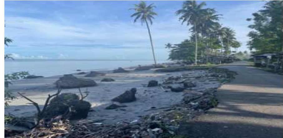
Kondisi wilayah pantai pasangkayu akibat gelombang dan abrasi
